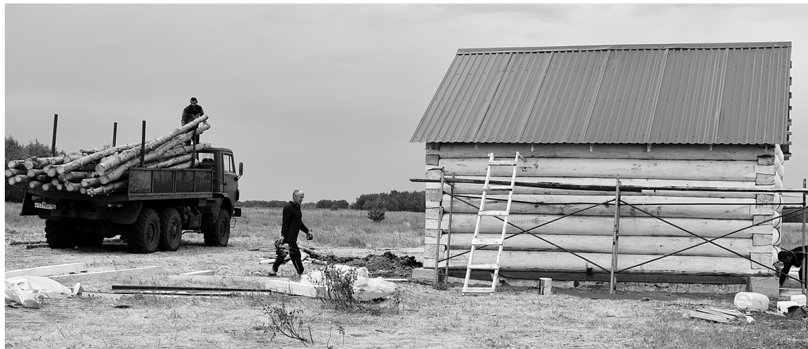
На территории строится баня
