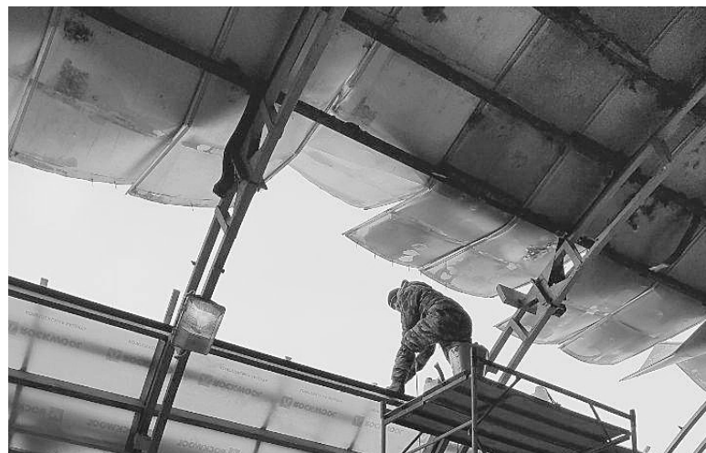
Ремонт стадиона проходил в течение нескольких месяцев, заменена кровля, отопление, освещение, полы
