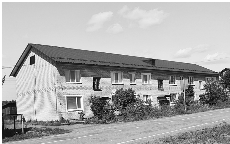
Дома в райцентре преобразились после ремонта
