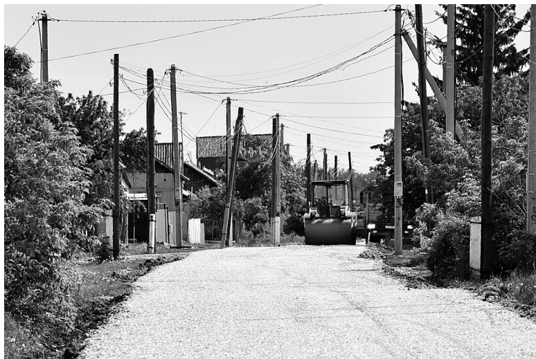
По ремонту муниципальных дорог работы выполнены в полном объеме
