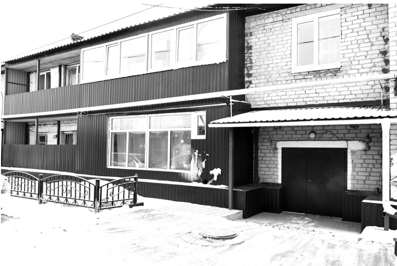
После ремонта дом по улице Молодежной, 7 не узнать – новая крыша и балконы
