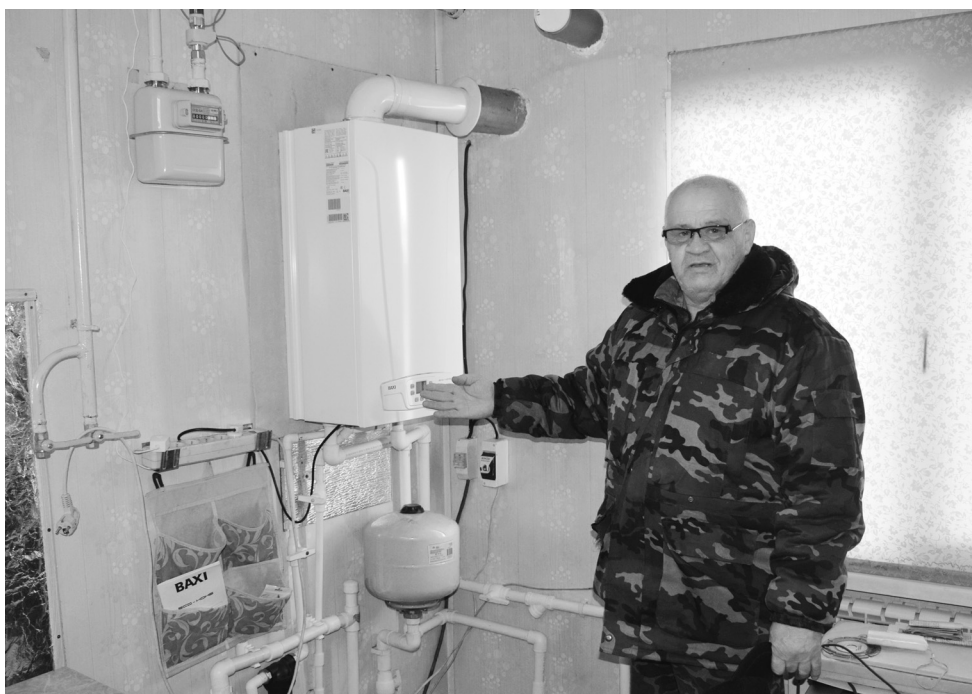
Дмитрий Толкачев установил газовое оборудование в отдельном помещении
