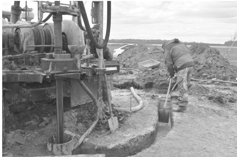
Летом проводился большой объем ремонтных работ на центральном водоводе в Бердюжье. Старые чугунные трубы заменили на современные и долговечные
