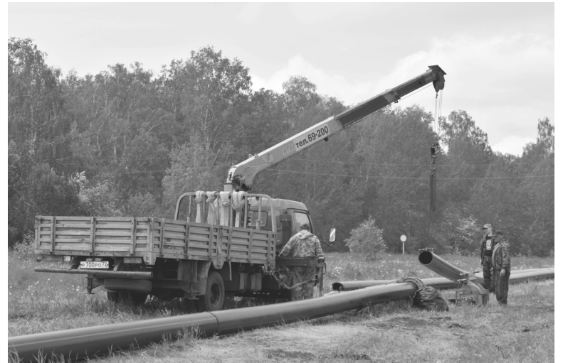
Летом проводился большой объем ремонтных работ на центральном водоводе в Бердюжье. Старые чугунные трубы заменили на современные и долговечные
